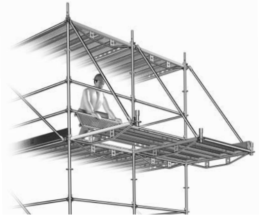
2 Les planchers suivants sont ensuite posés et poussés au fur et à mesure pour assurer un platelage complet.
