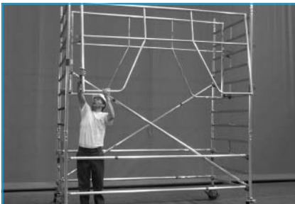
3 - Pose des garde-cors de sécurité définitifs.
